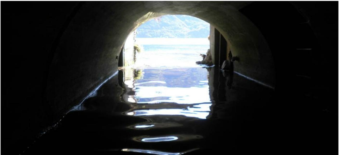
Le mandat concerne l'inspection et le relevé des canaux et cours d'eau souterrains sur le territoire de Lugano sur une longueur totale d'environ 2'000 m. L'inspection optique des canaux a été effectuée avec caméra télécommandée (inspection vidéo) ou par la visite du cours d'eau canalisé en fonction de l'accessibilité du diamètre de son conduit.
