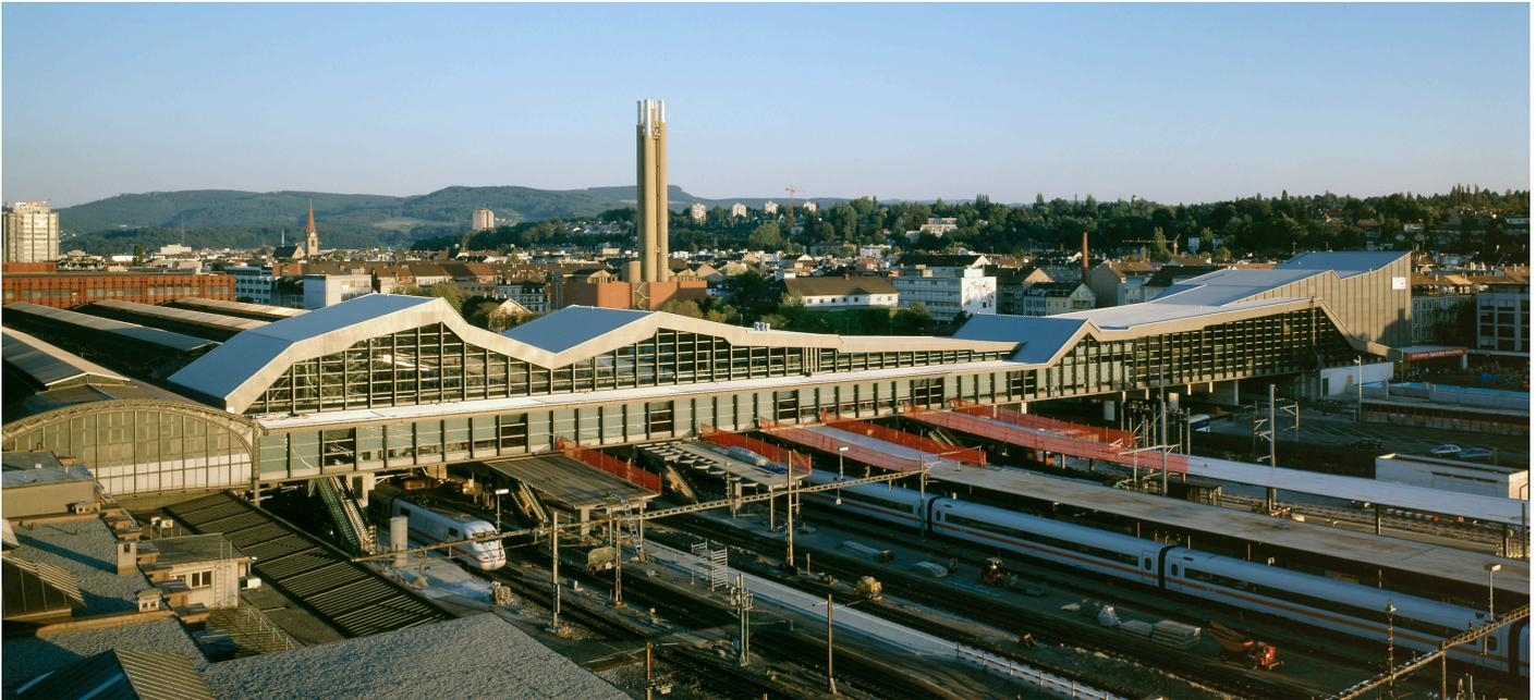
Im Rahmen der Erweiterung des Basler Hauptbahnhofs wurde ein Brückenbauwerk errichtet, das das historische Reisezentrum mit dem neuen Einkaufszentrum im südlichen Teil des Bahnhofs verbindet. Es handelt sich um einen vorgespannten Stahlbetonkasten mit einem Grundriss von 30x183 m und einer Trägerhöhe von 1,1 m. Dank dem eingesetzten Taktschiebeverfahren war es möglich, während dem Bau den Bahnverkehr für den gesamten Bahnhof in Betrieb zu halten.
