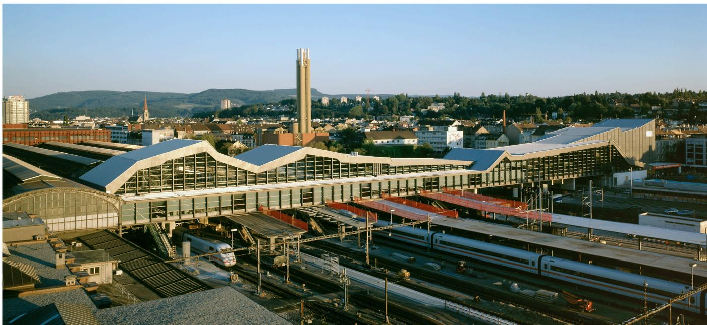
Nell'ambito dell'estensione della Stazione Centrale di Basilea è stata realizzata una struttura a ponte che congiunge la storica biglietteria al nuovo centro commerciale nella parte sud della stazione. Si tratta di un cassone in calcestruzzo armato precompresso con dimensioni in pianta pari a 30x183 m, ed altezza della nervatura pari a 1.1 m. Grazie alla metodologia di varo a spinta del cassone è stato possibile mantenere il traffico in esercizio per l'intera stazione.
