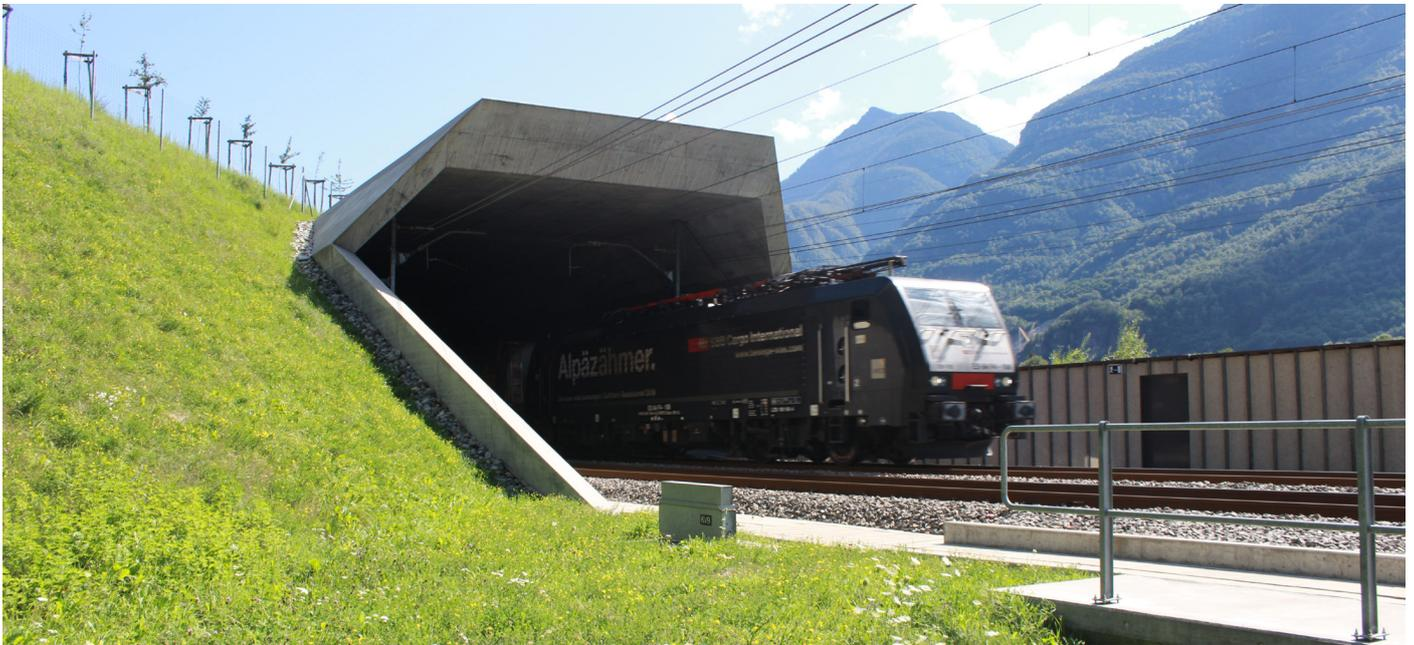
Dans le cadre du projet du nœud de la Giustizia (lot 626) afférent à la nouvelle ligne ferroviaire ATG du secteur de Biasca, une nouvelle tranchée couverte a été projetée et réalisée, attenante au côté sud du pont sur la Froda.
